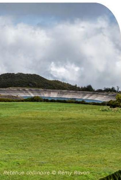
Des retenues collinaires ont été construites au niveau de divers points bas : il s'agit **d'ouvrages hydrauliques conçus pour recueillir et stocker les eaux de ruissellement** provenant des précipitations dans les zones vallonnées ou en pente. Les retenues collinaires des Herbes Blanches, de Piton Marcelin, de Piton Rouge ou de Piton Sahales sont essentielles pour l'irrigation agricole et la défense contre les feux de forêts.
